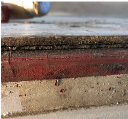
⚓ Rumpf-Deckverbindung alt
