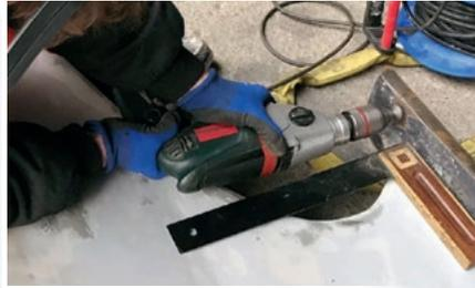
⚓ vorhandene Löcher werden mit Senkkopf aufgebohrt
